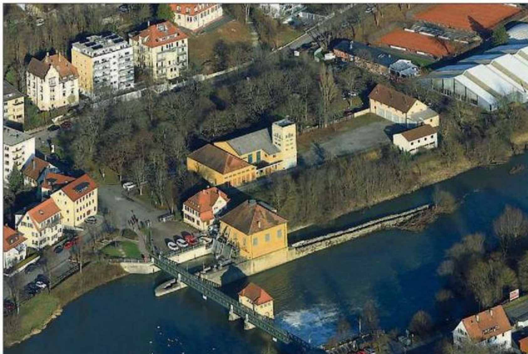
Auf der asphaltierten Fläche rechts der Bildmitte und der Brückenstraße ist Platz für ein Haus. .
